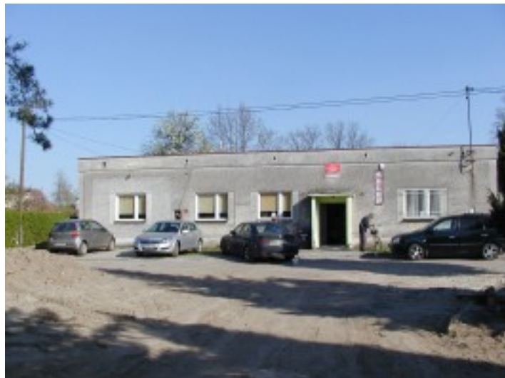
Zdjęcie 1 Widok budynku od strony frontowej.
