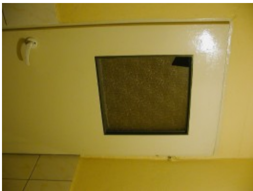
Zdjęcie 20 Ubytek szyby w drzwiach do kabiny WC.
