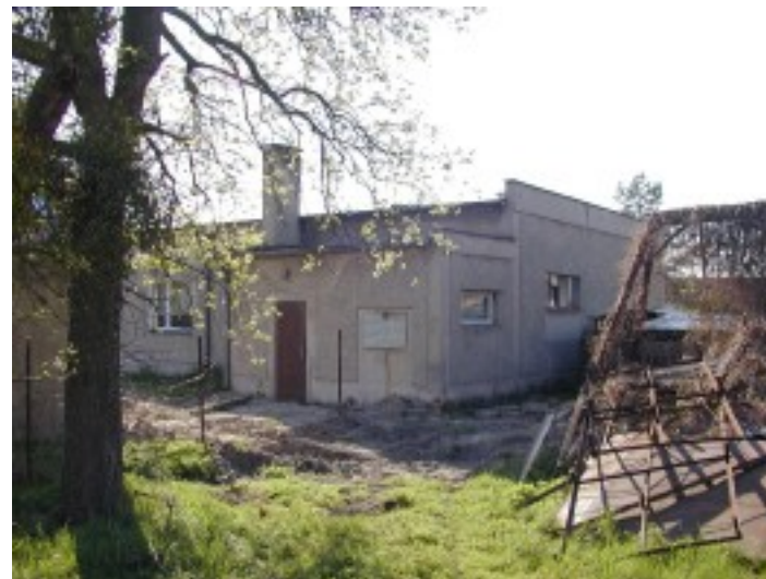
Zdjęcie 2 Widok budynku od strony bocznej/ tylnej.
